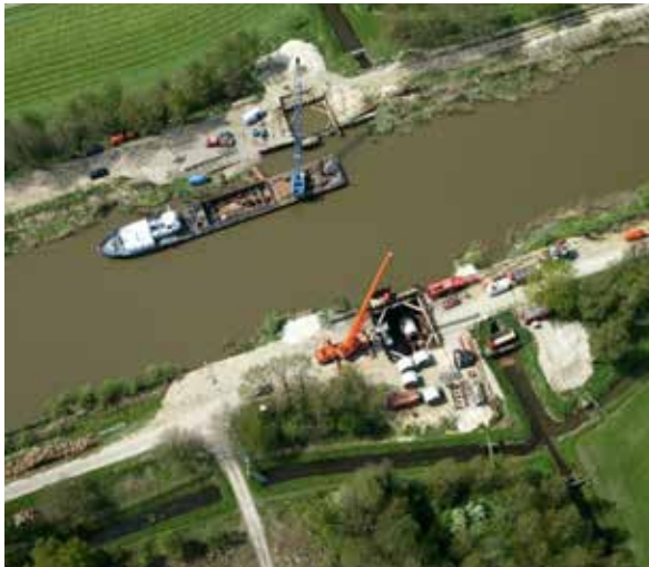
Uitvoering kruising Doorbraak zijtak Twentekanaal (zwerfkeien problematiek)
